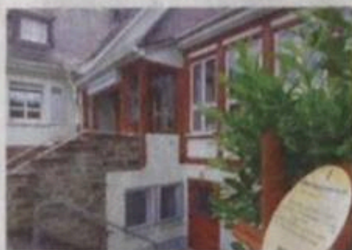
1924 als Schule gebaut: Die Begegnungsstätte kommt in die Jahre.
